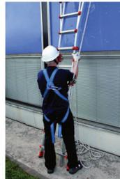
AVVICINARE LA SCALA A PIOLI ALLA CORDA. COLLEGARE L'IMBRACATURA ALLA CORDA TRAMITE IL DISSIPATORE.
